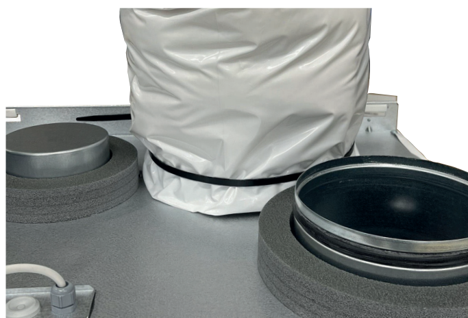
Ferdig montert kanal.
